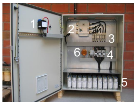
Figuur 7: Condensatorbatterij (bron: Wikipedia) met '5' de condensatoren
