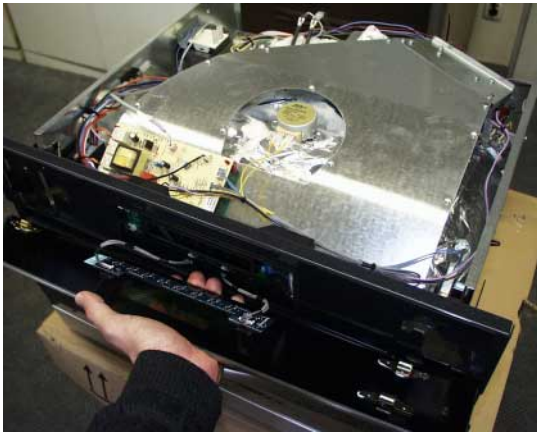
Afbeelding.: Schakelaarpaneel na de demontage
