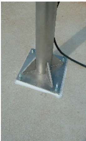
Flensbevestiging direct op het dakvlak
